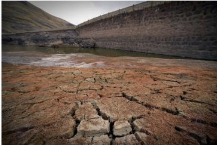
La tierra de la represa de Hampaturi esta totalmente seca. Foto: La Razón
